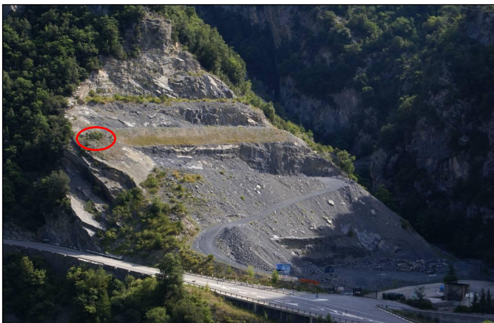
Localisation des stations d'Aristoloché sur la carrière (Photo SEGED, 19/08/2013)
