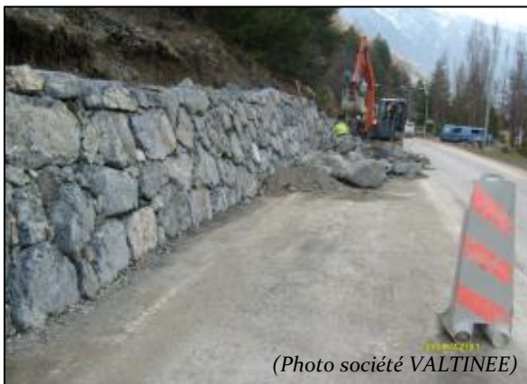
Mur en enrochement RM2205 Isola
