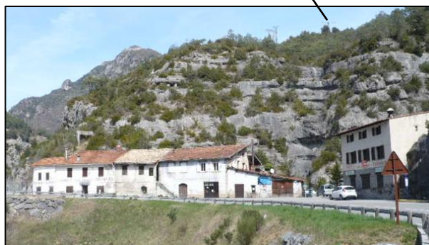
Commerces et bâtiments à l'abandon (environ 450 m en aval)
